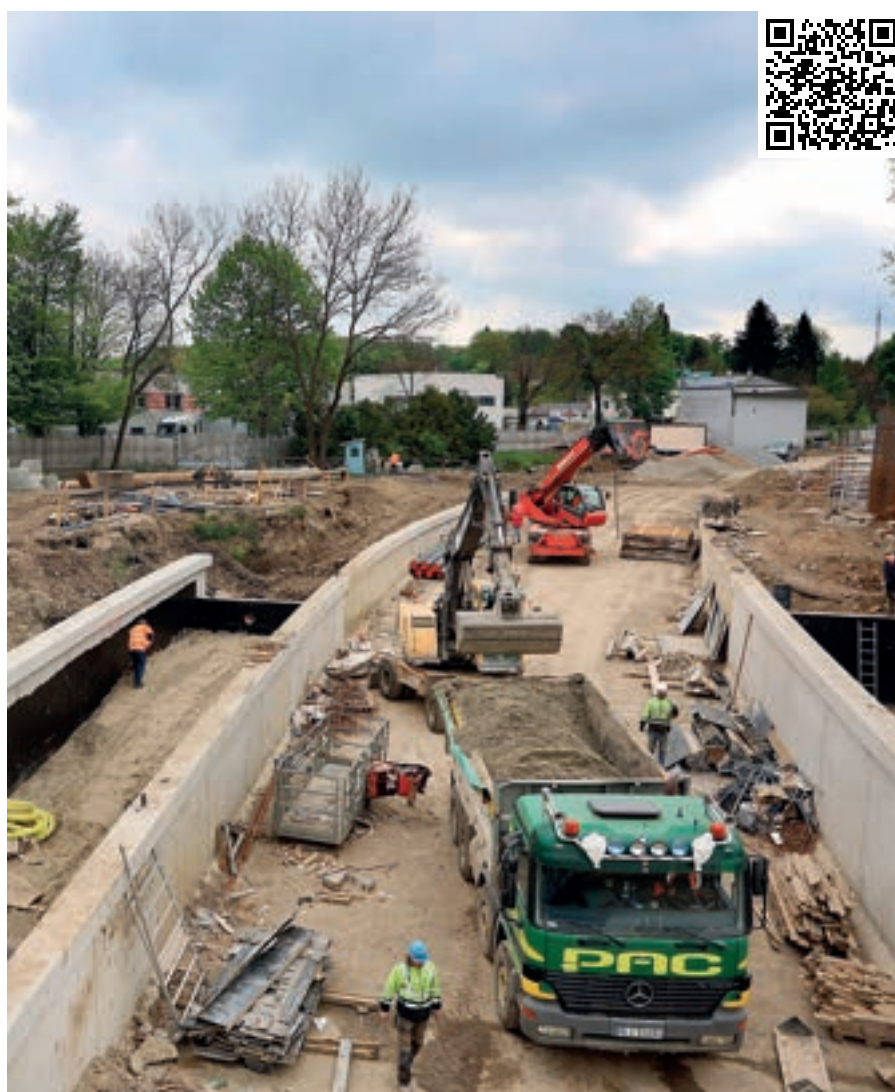
Budowa tunelu w Łańcucie idzie zgodnie z planem
