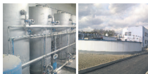
Stacja uzdatnia wody Lubaszowa po modernizacji
