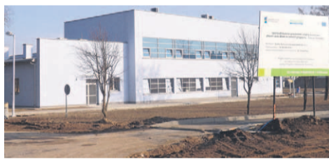
OŚ Tuchów – budynek administracyjny
