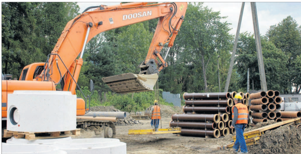
Budowa sieci kanalizacyjnej w gminie Nawojowa
