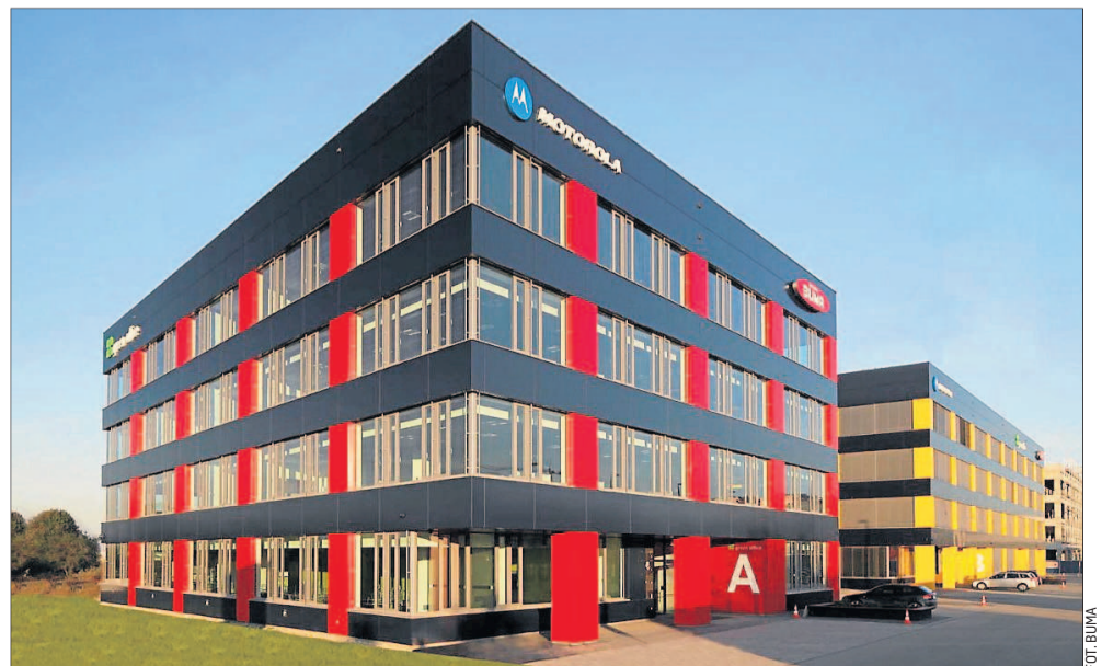
Sukcesem zakończyła się m.in. komercjalizacja budynków realizowanych przez firmę Buma
