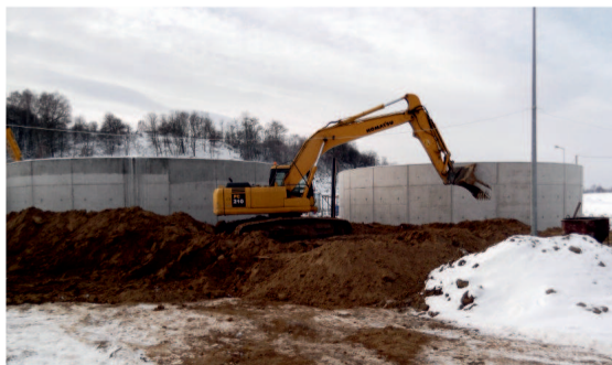
Prace prowadzone przy oczyszczalni ścieków w Tuchowie
