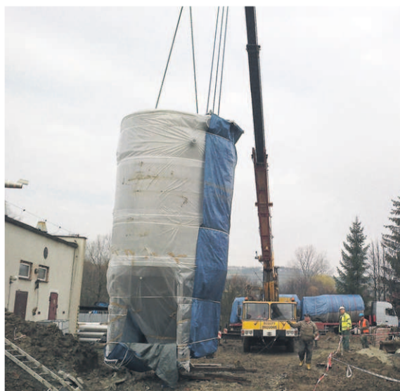
Prace prowadzone przy stacji uzdatniania wody w Lubaszowej
