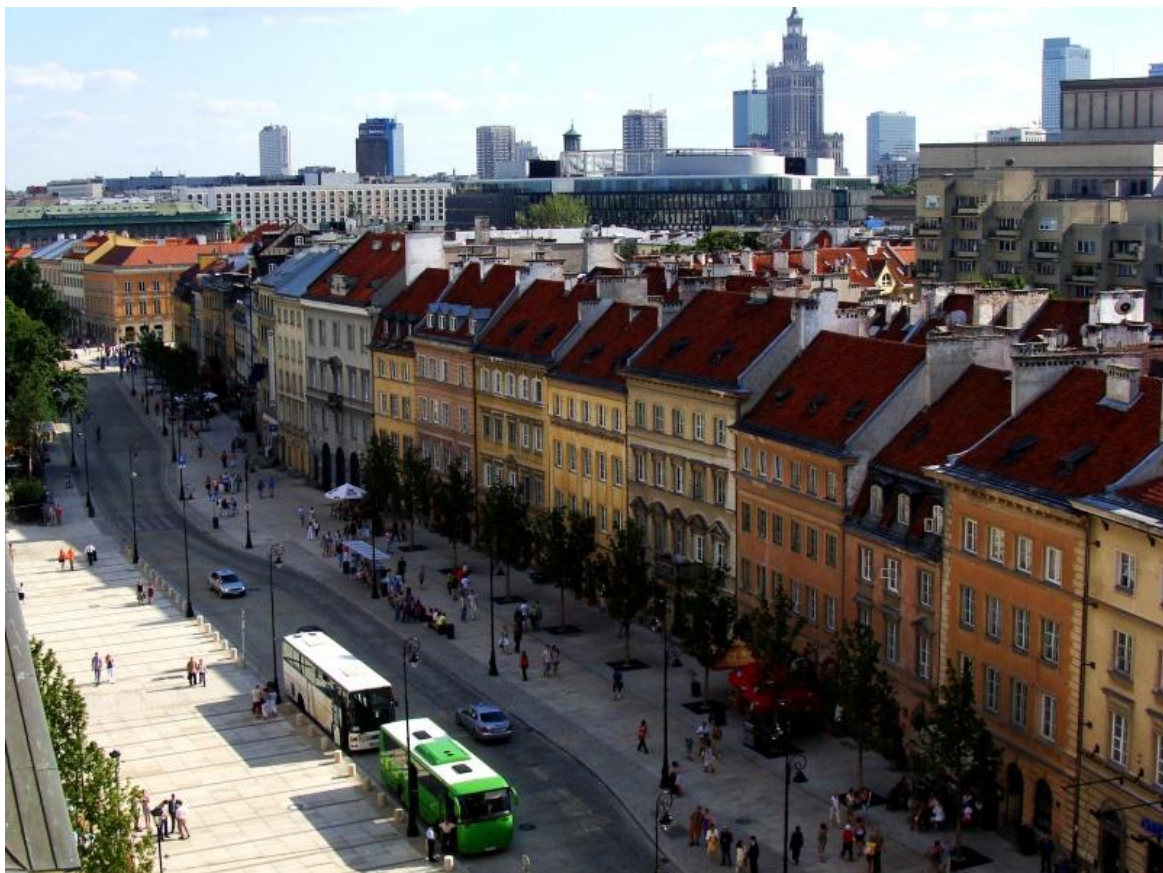
Warszawa, Krakowskie Przedmieście po przeprowadzeniu kompletnej przebudowy
