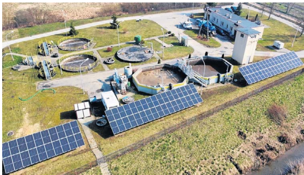
Oczyszczalnia ścieków z instalacją fotowoltaiczną
