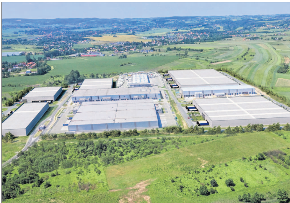
W Zabierzowie powstaje imponująca swą skalą Goodman Kraków Airport Logistics Centre
